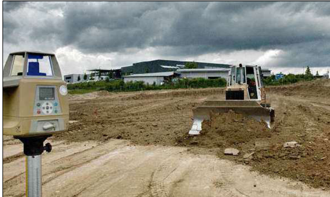
Der Fahrer der Planiermaaschine zieht unbeirrt von den dunklen Wolken seine Bahnen. Bis zum Winter soll hier eine 25 mal 50 Meter große Halle stehen. – Foto: Rücker
